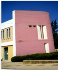
Figure 7: façade sud ouest du bloc 13 de l'université de Blida
